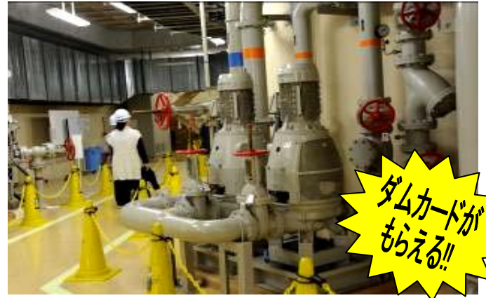
奥只見発電所
